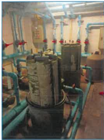
ภาพถ่ายที่ 2.2-11(2) การล้างทำความสะอาดถังน้ำใช้และระบบกรองน้ำใช้ (ต่อ)
