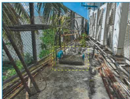
ภาพถ่ายที่ 2.2-16(2) ระบบท่อ vent พิวชีเพื่อระบาย ก๊าซมีเทน
