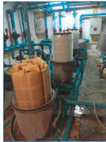
ภาพถ่ายที่ 2.2-11(2) การล้างทำความสะอาดถังน้ำใช้และระบบกรองน้ำใช้ (ต่อ)
