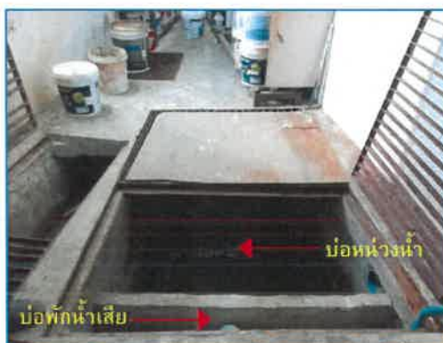
ภาพถ่ายที่ 2.2-13 บ่อหน่วงน้ำและบ่อพักน้ำเสีย พร้อมตะแกรงดักมูลฝอย
