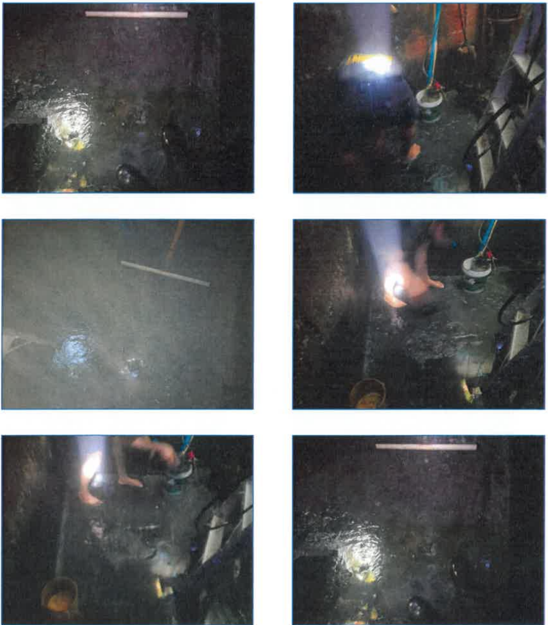
ภาพถ่ายที่ 2.2-14 การลอกตะกอนจากรางระบายน้ำและบ่อพักน้ำ
